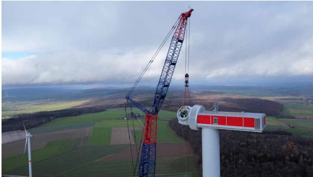
Foto: Bau der neuen Windenergieanlage in Bad Gandersheim
