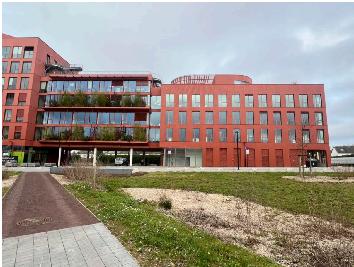
Photo: Immeuble du Bois Lilas, Siège social de l'entreprise Energiequelle SAS
