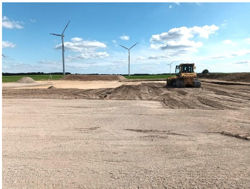
Chantier à Krummensee
