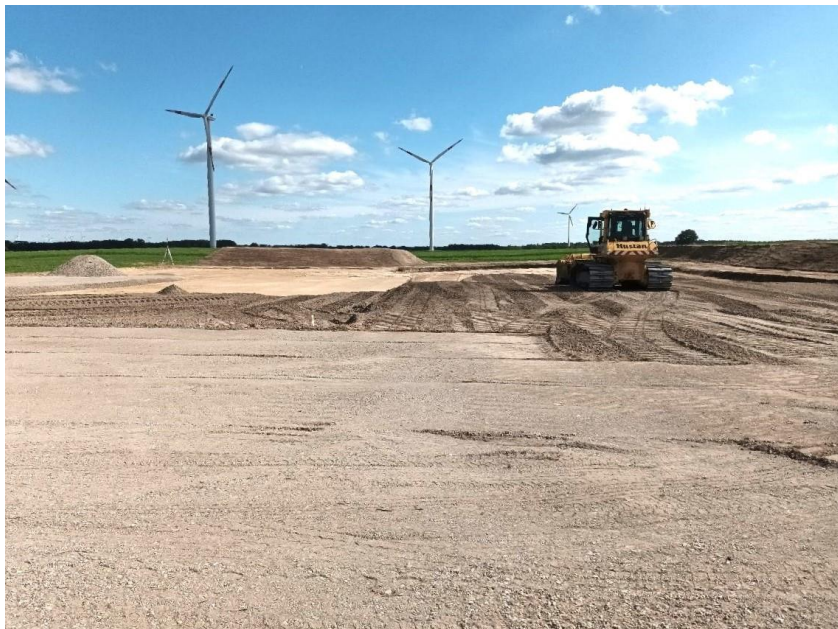
Kuva: Rakennustyöt Krummenseessä
