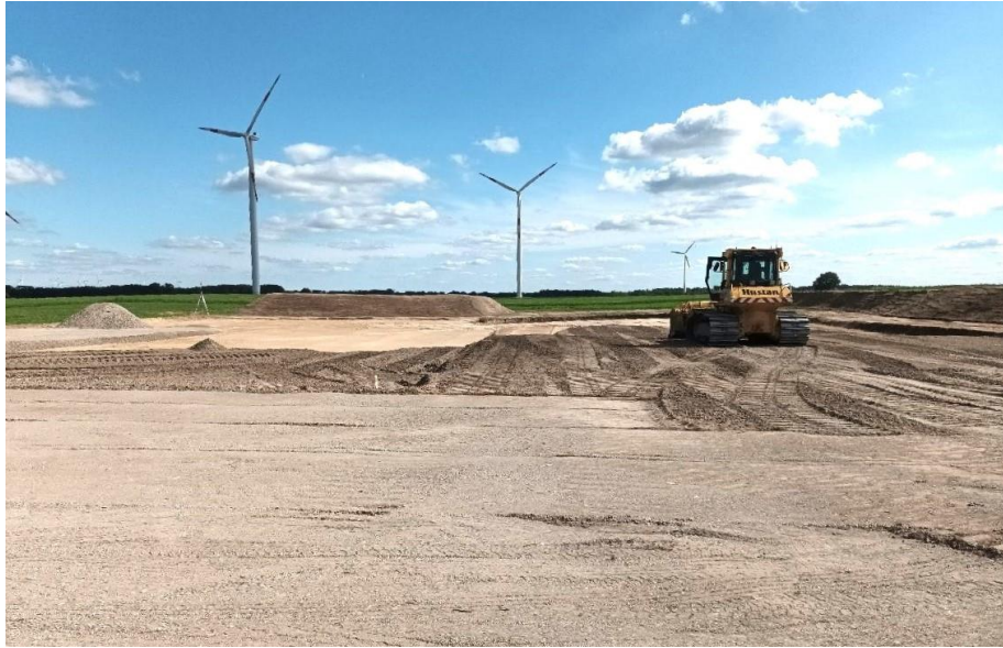
Foto: Bauarbeiten in Krummensee
