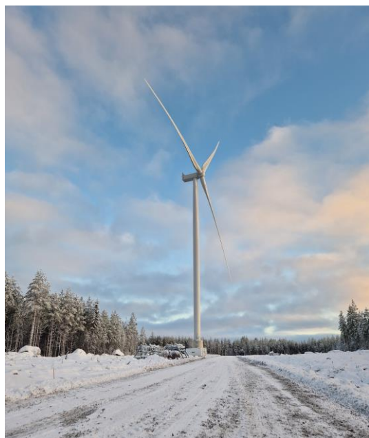
Parc éolien de Torvenkylä
