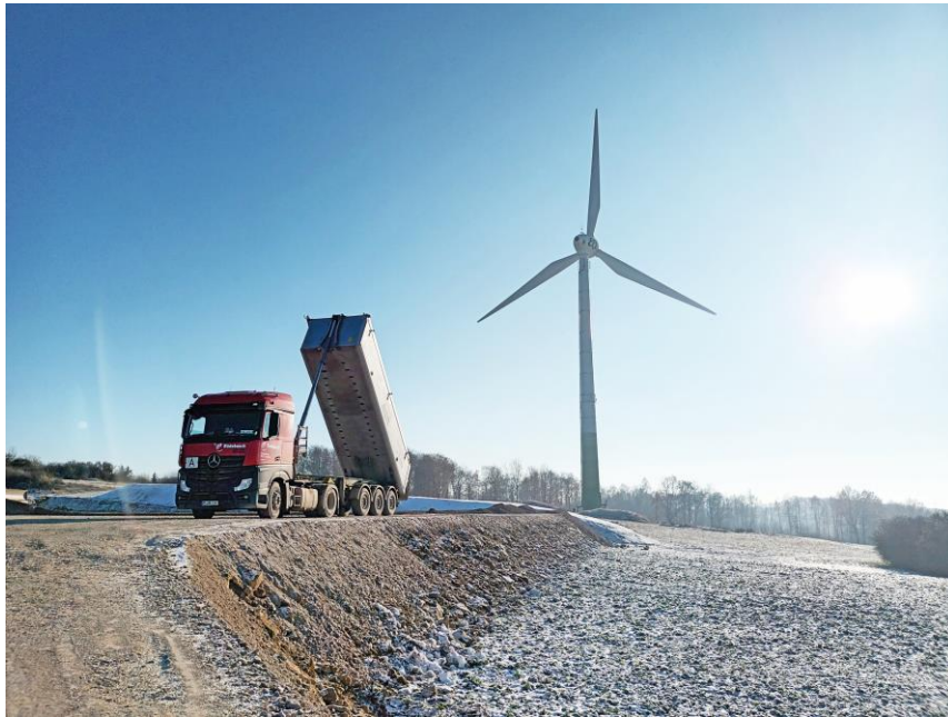
Foto: Bauarbeiten in Bad Gandersheim
