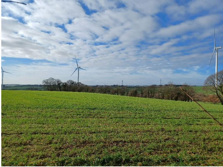
Le Méneac wind farm in Loudéac and Trévé (Côtes d'Armor)
