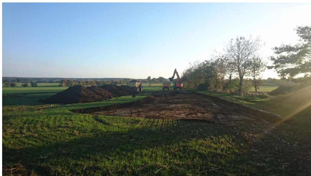
Photo : Chantier de Saint-Morand
