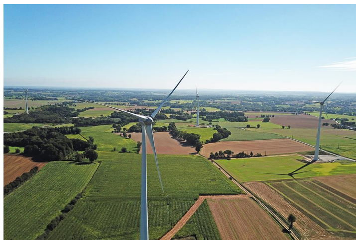
Parc éolien de Broons/Biterne-Sud
