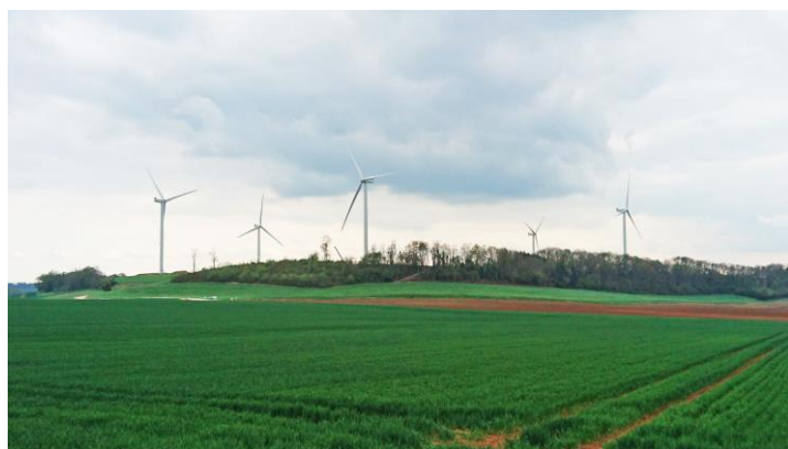
Parc éolien de Villers-le-Tourneur
