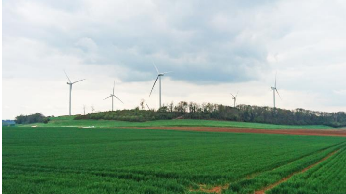
Villers-le-Tourneur wind farm
