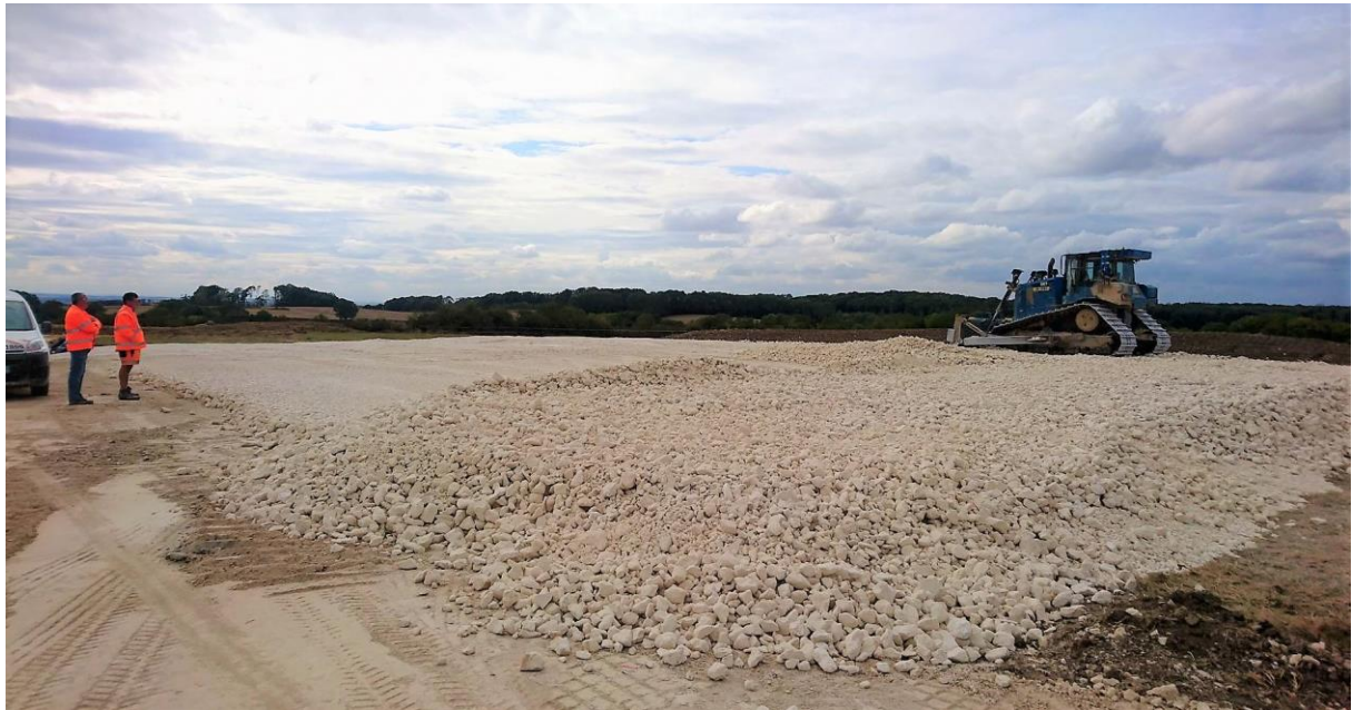
Baustelle Villers le Tourneur
