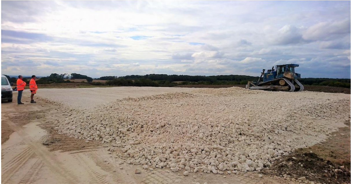
Villers-le-Tourneur construction site
