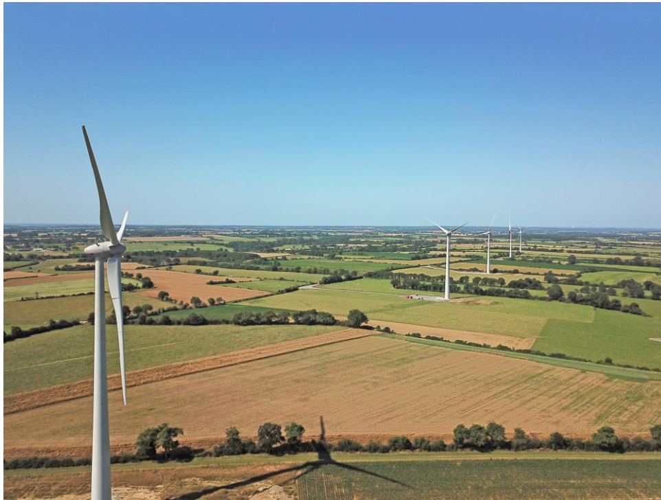
Windpark La Chapelle-Glain. Foto: P&T Technologie
