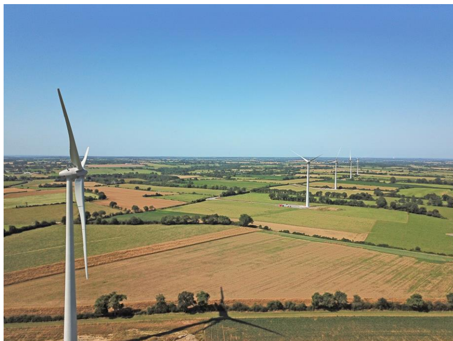
Parc éolien de La Chapelle-Glain. Photo : P&T Technologie
