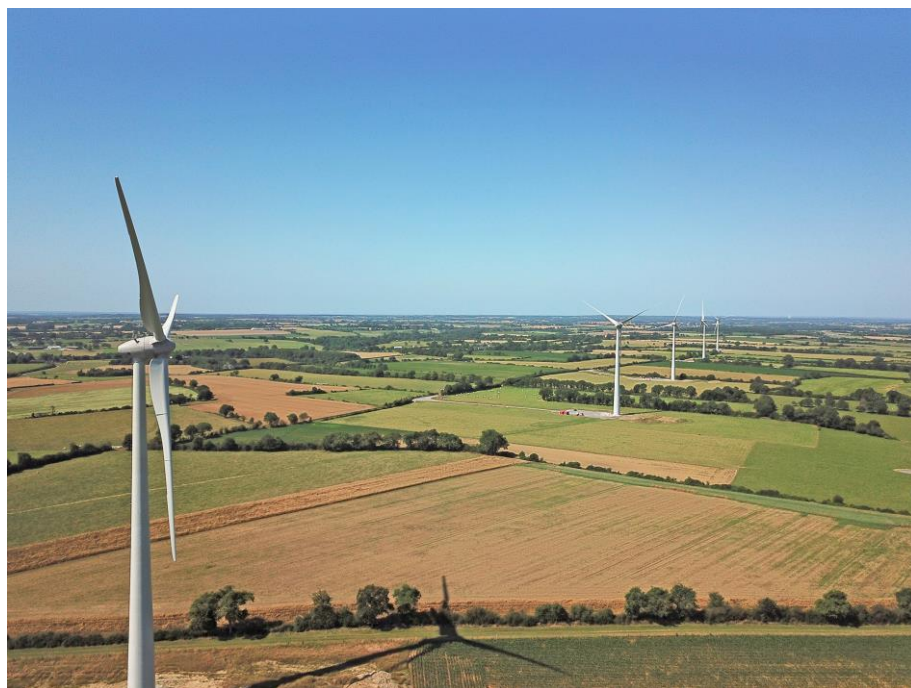
La Chapelle-Glainin tuulivoimapuisto. Kuva: P&T Technologie
