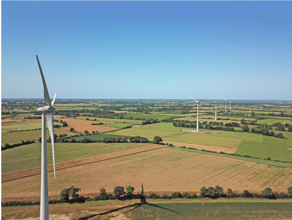
La Chapelle-Glain wind farm Photo: P&T Technologie
