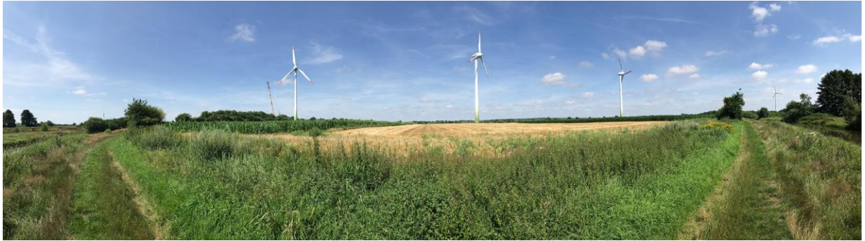
Parc éolien d'Esterwegen : trois éoliennes de type Enercon E-58 vont être remplacées par deux E-138.
