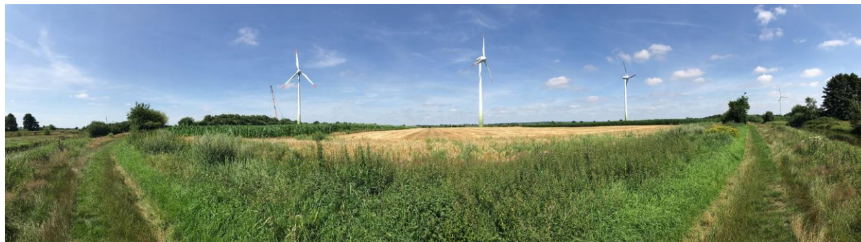
Esterwegenin tuulivoimapuisto: Kolme Enercon E-58 –tyypin voimalaa korvataan kahdella E-138 –voimalalla.
