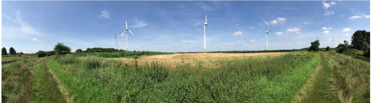
Windpark Esterwegen: Drei Anlagen des Typs Enercon E-58 werden durch zwei E-138 ersetzt.
