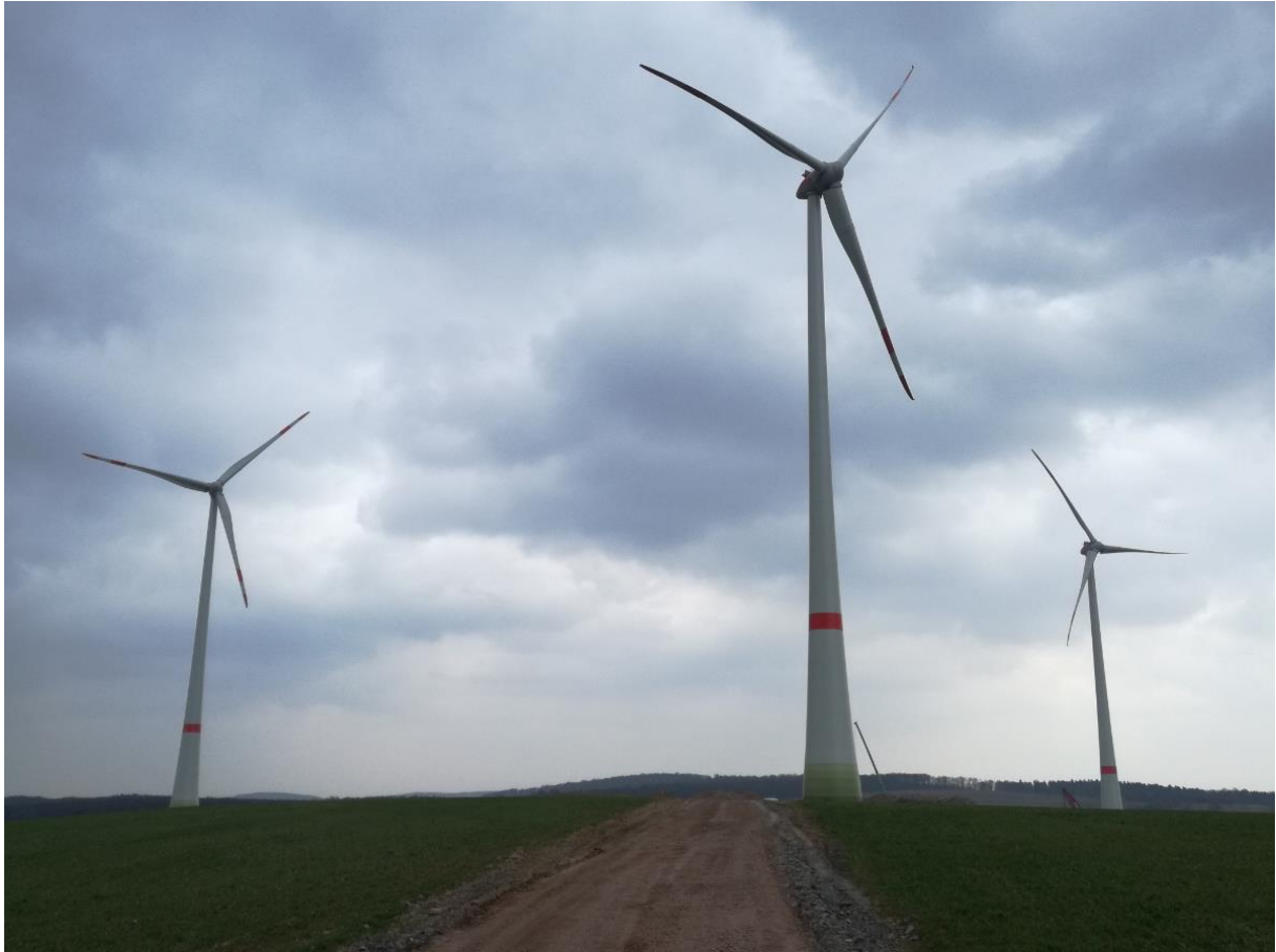
Windpark Uthleben, ganz rechts: Mitarbeiteranlage.
